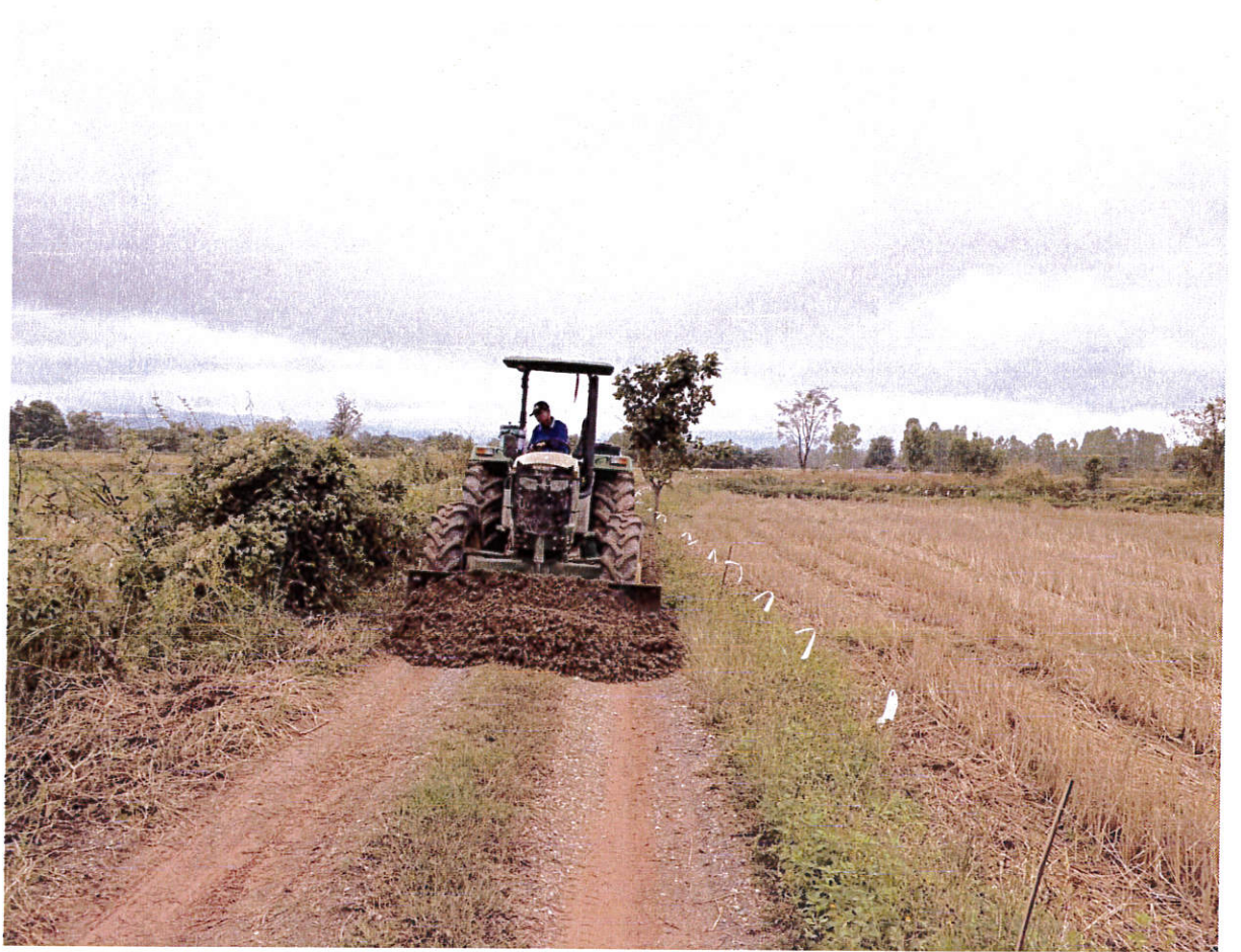
ซ่อมแซมถนนหินคลุกการเกษตรตำบลแม่ใส หมู่ที่ ๓
